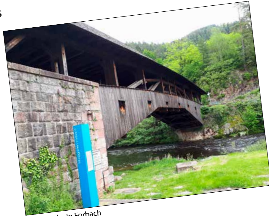
Holzbrücke in Forbach
